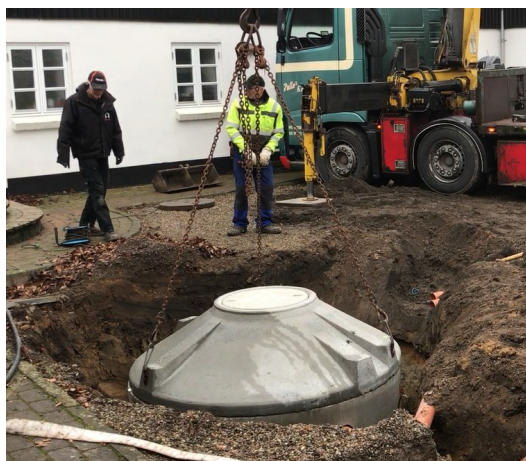
En BioKube beton 5PE bliver installeret
